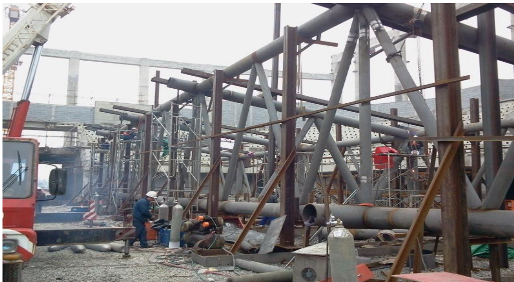
图 2 类似工程桁架拼装胎架设置照片
